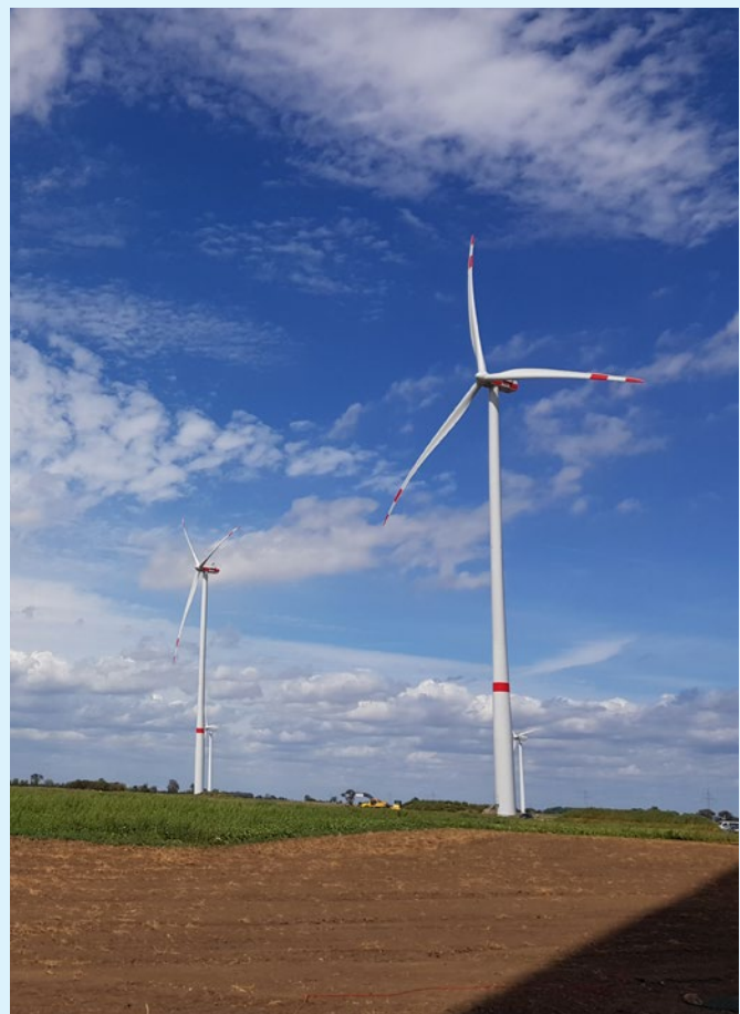
Der Windpark Wörbzig wird erweitert
