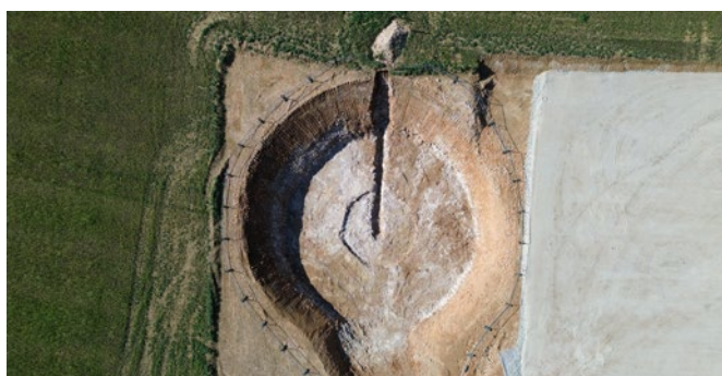
Fundamentaushub im Windpark Poilly
