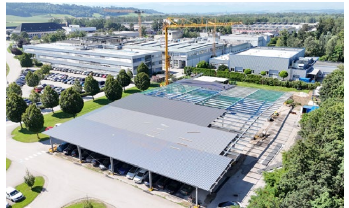
Hier entsteht die Dachfläche, auf der später 1.352 Module Platz finden
