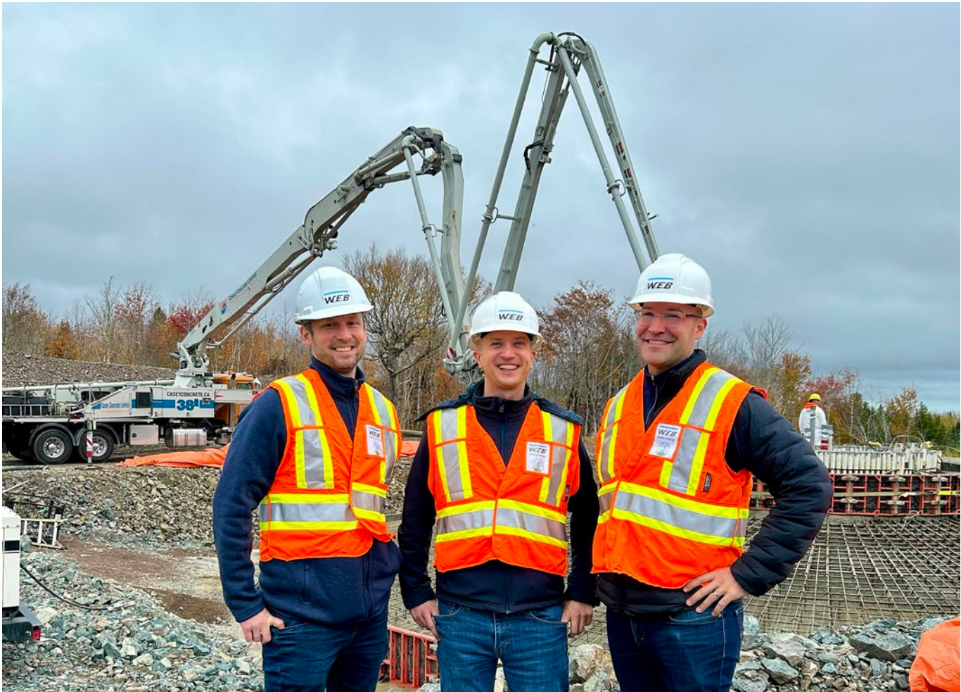
Bei einer Baustellenbesichtigung in Weavers Mountain, wo derzeit ein neues Windprojekt mit rund 94 MW entsteht, informierte sich Florian Müller gemeinsam mit den lokalen Geschäftsführern Stefan Karkulik und Rory Cantwell über den Fortschritt der Arbeiten
