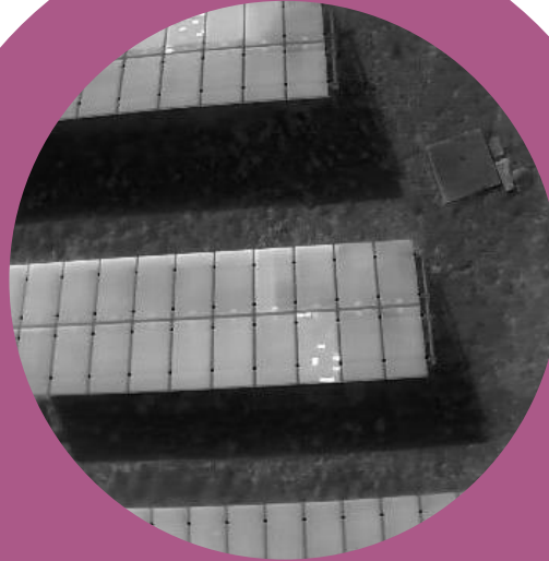
Hotspots durch defekte Zelle
