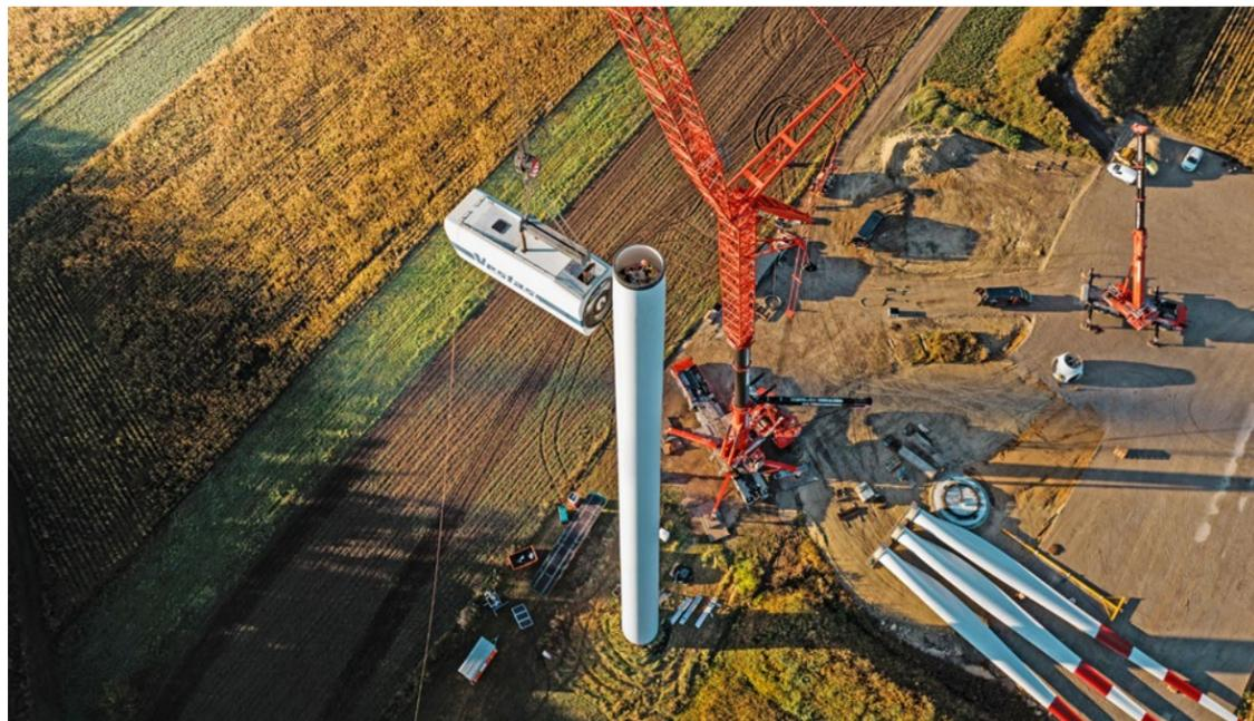
Les éoliennes sont démontées avec soin car elles seront réinstallées ailleurs, puis remises en service.
