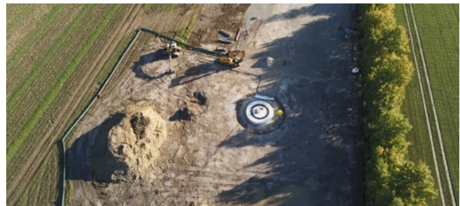
Das Fundament wird für ein neues Windrad vorbereitet. Bauarbeiter und Bagger sind mit den Erdarbeiten beschäftigt.
