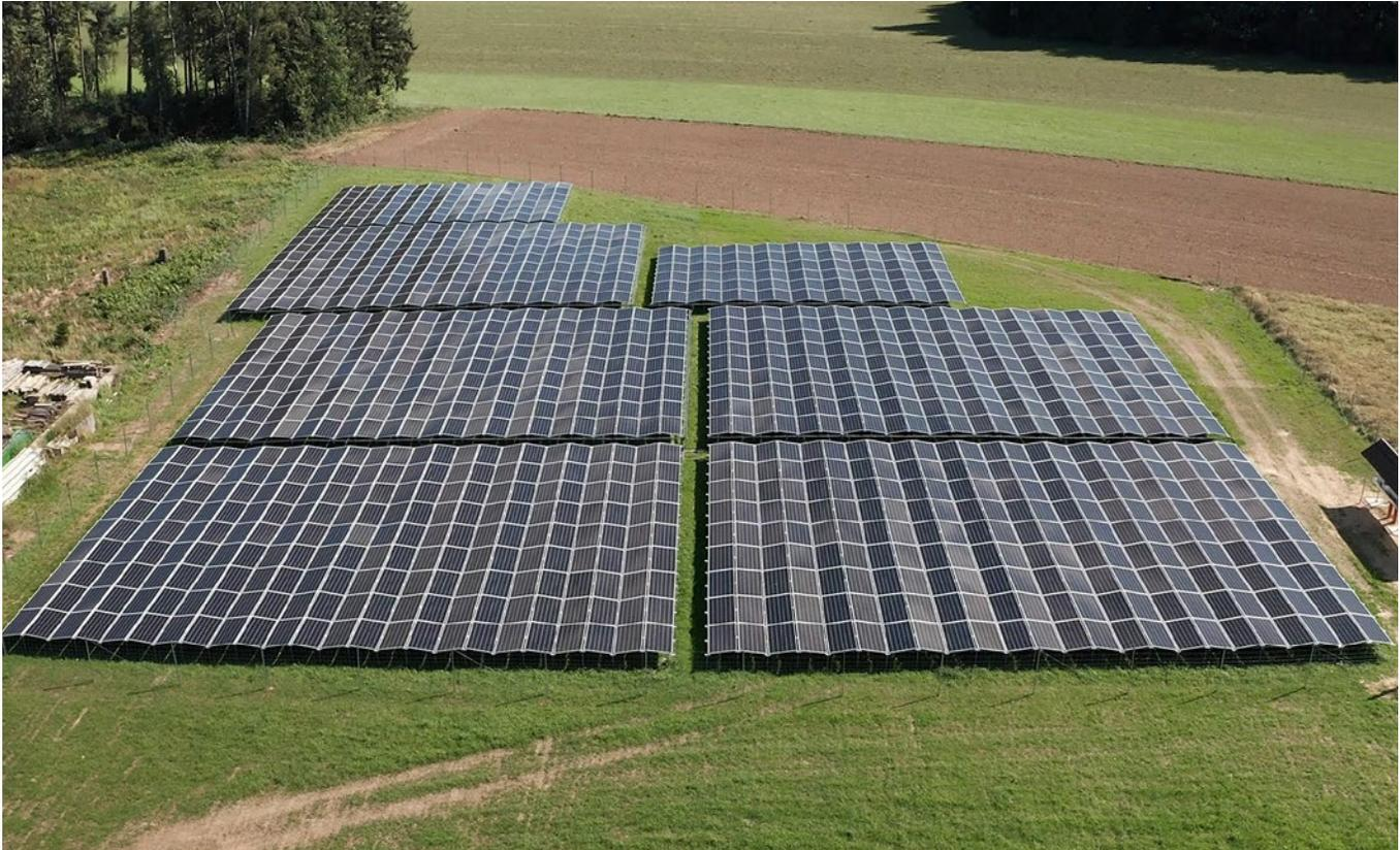
Hinter der Halle wurde auf einer Fläche von 4.436 m<sup>2</sup> das „Ost-West-System“ montiert. Die PV-Leistung in der Firmenzentrale beläuft sich auf 750 kW<sub>p</sub>.
