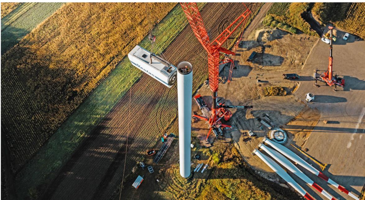
Sorgfältig werden die Windkraftanlagen abgebaut, da sie an anderer Stelle wieder aufgebaut und weiter genutzt werden.
