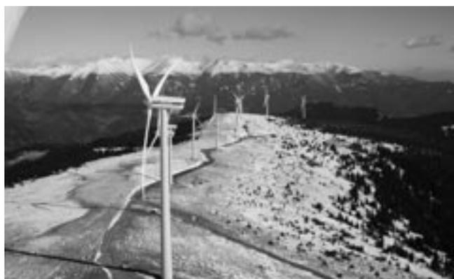
Der Tauernwindpark wird pro Jahr ca. 39 Millionen Kilowattstunden sauberen Strom erzeugen. Das bedeutet die Versorgung von 15.000 Haushalten oder 0,8% des steirischen Stromverbrauchs. Der Tauernwindpark ersetzt 12.000 - 15.000 Tonnen Erdöl und erspart der Umwelt den Ausstoß von 37.000 Tonnen Kohlendioxid.
