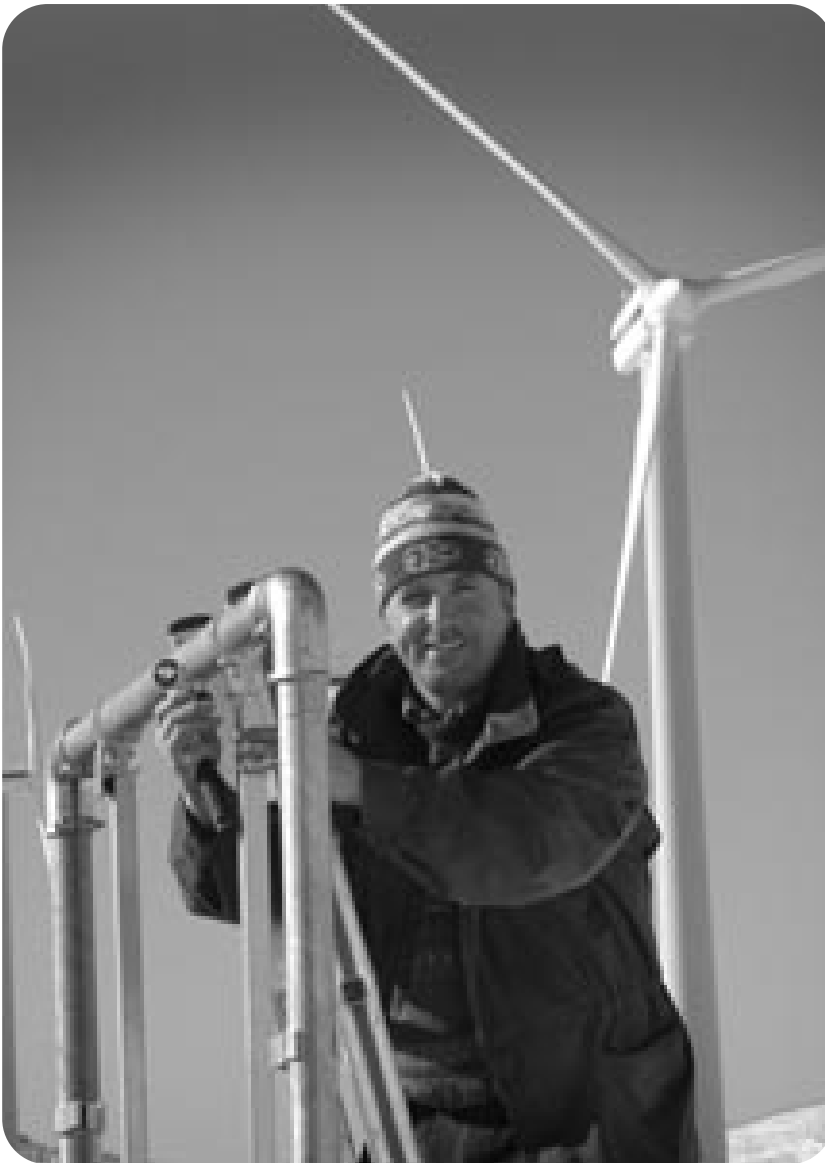
Anfang November wurde vom Mühlenwart des Tauernwindparks, Herrn Rudolf Wiesnegger, eine Informationstafel der WEB Windenergie AG im Tauernwindpark montiert.
