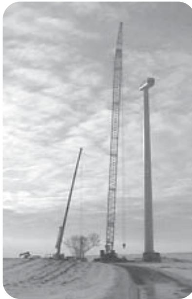
*In Vielau, im Südwesten Sachsens wurde zwischen 27. und 29. Dezember die 75. WEB-Windturbine errichtet. Zwei Tage wurde die V 66/ 1750 kW montiert und spulte nun die ersten Kilowattstunden Ökostrom auf die Zähler.*
