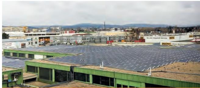
**Kraftwerke:** 2 Photovoltaik-Anlagen mit je 350 kW<sub>p</sub>
