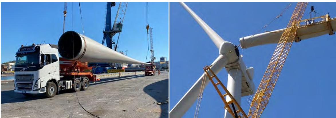
In Piombino musste nach einem Blitzschaden der gesamte Rotorblattsatz ausgetauscht werden.
