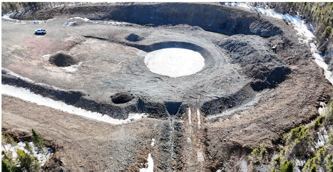
Die Basisschicht des Fundaments wurde bei allen 16 Anlagen in Weavers Mountain gegossen
